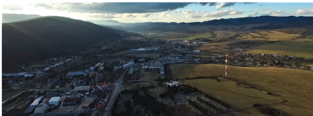
Obr. 2. Pohľad na východnú (a) a západnú (b) časť mesta s monitorovanými zónami 1 – 7 (obr. 1). Foto: J. Ščavnický. Fig. 2. View of an eastern part (a) and a western (b) part of the town with surveyed zones 1–7 (Fig. 1). Photo by J. Ščavnický.
